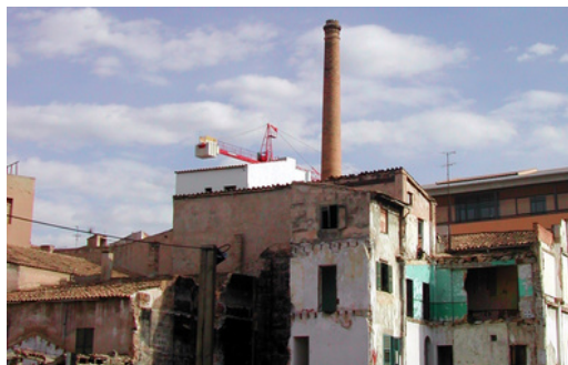
Estat del barri de sa Gerreria durant el procés de rehabilitació. Fotografia de Chixoy.
