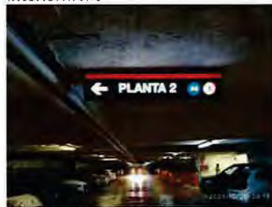
Senyalística interior aparcament
