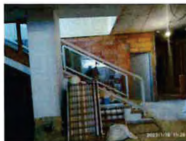
Obres adequació oficines SMAP 2 C/Fco. Rover
