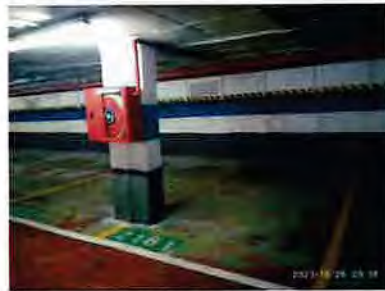
Adequació xarxa contraincendis
