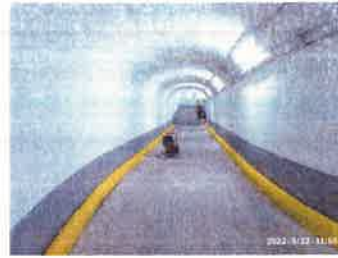
Finalització túnel d' en Coll.
