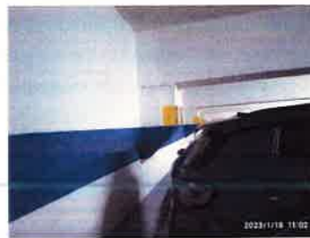
Mur nord PI 2 després.
