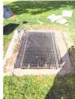
Reforç ventilació Parc de la Mar.
