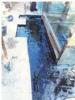
Nova impermeabilització nucli Sa Riera.
