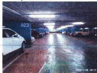
Recol·locació xapes metacrilat per a reconducció filtracions.
