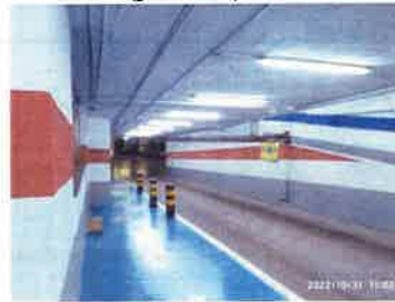
Pintura i nova il·luminació entrada aparcament.
