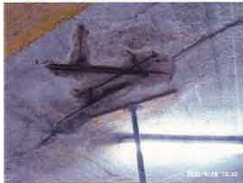
Repicat armadures forjat per a reparació PI 1.
