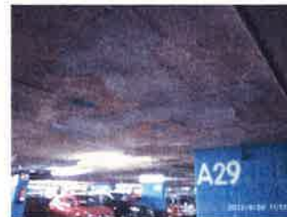
Acabat amb morter de reparació.
