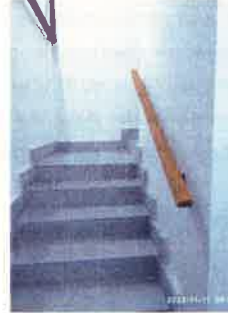
Nucli escales renovat.
