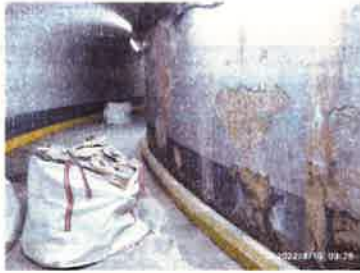
Treballs reparació túnel d' en Coll.
